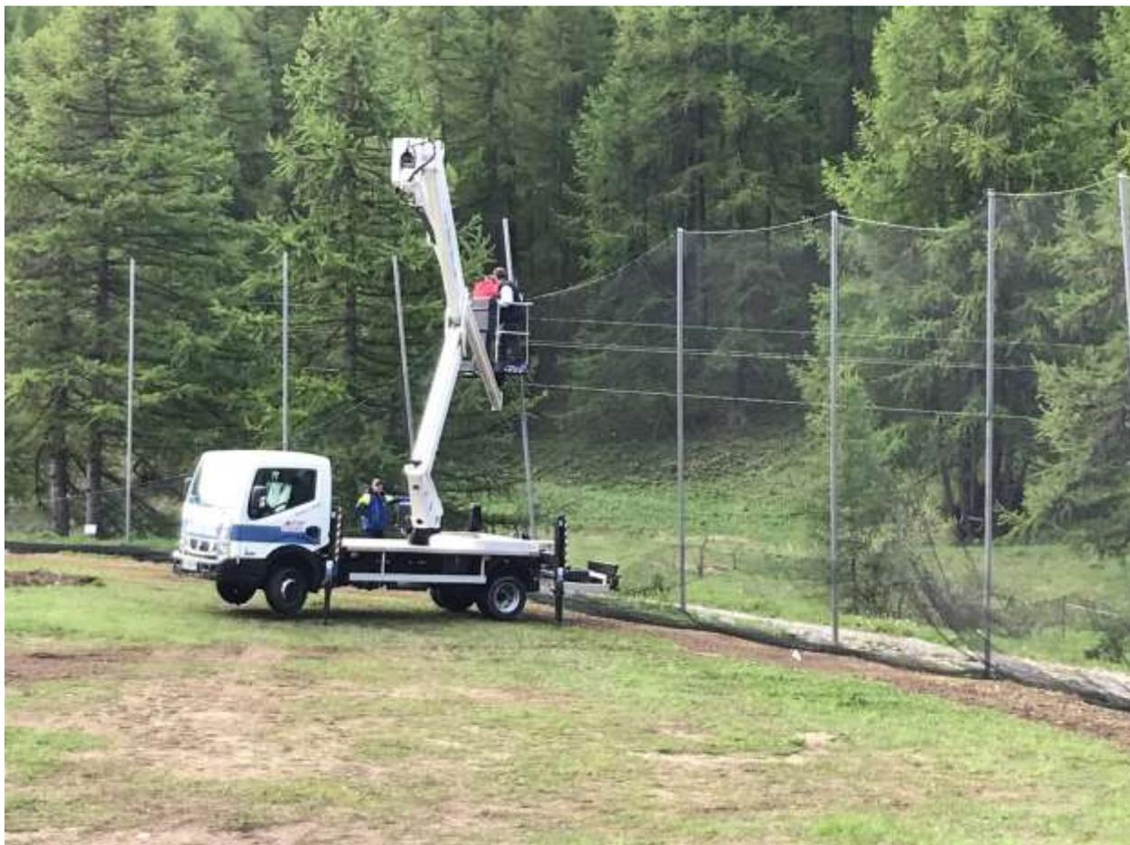
Installation des filets de protection, alors que le réseau d'arrosage vient d'être terminé. On voit d'ailleurs, sur la photo ci-dessus, les marques de terrassement.
