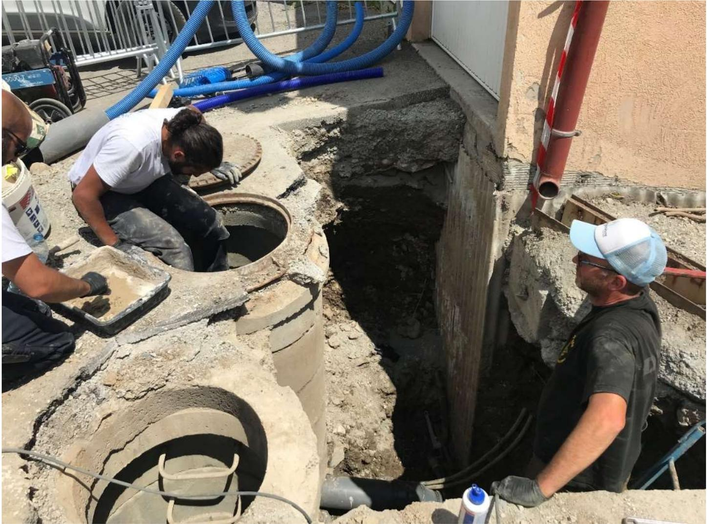
**S'agissant des HLM de la Voie Romaine, à l'ouverture de la fouille, le service a été confronté à la difficulté de réparer, cette fuite, car en effet le réseau d'assainissement pas au-dessus du réseau d'eau potable.**
