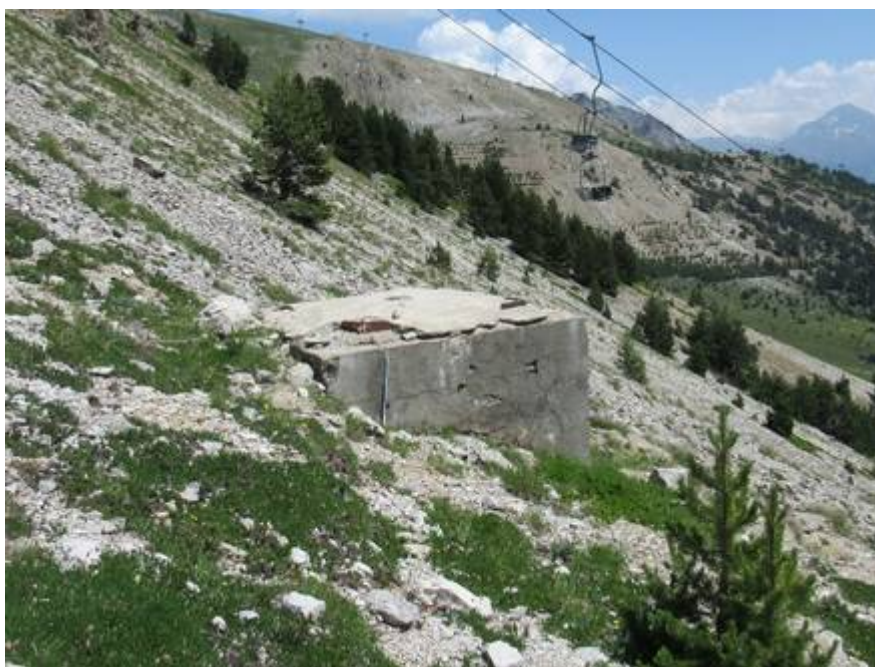
Figure 3 : Massif béton à araser, non propice aux Chiroptères
