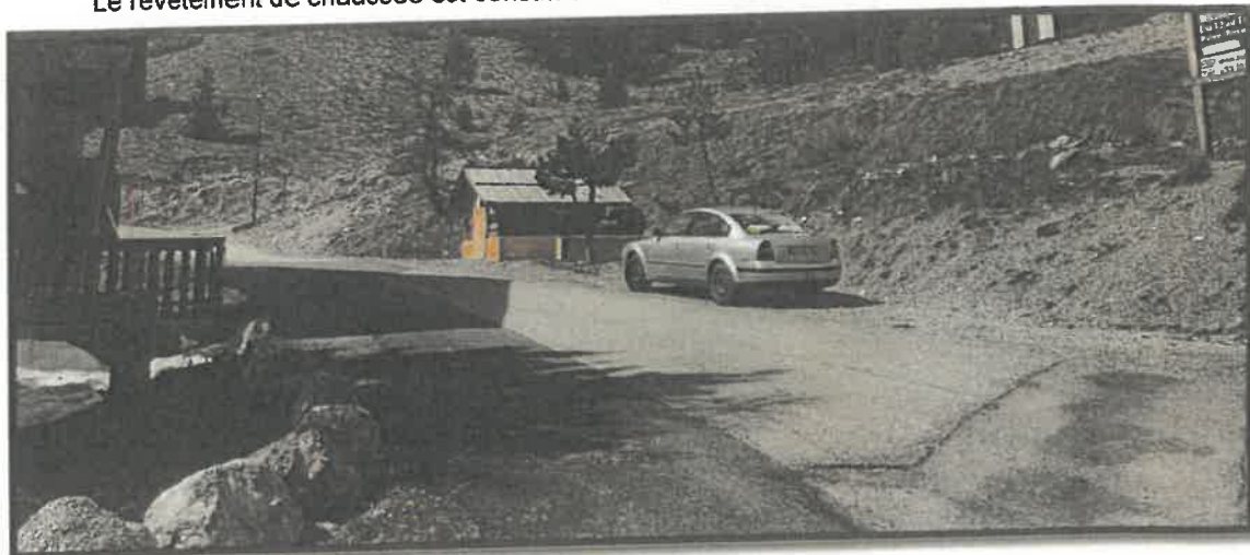
Figure 2 – Voie Communale « Rue de La Combe »
